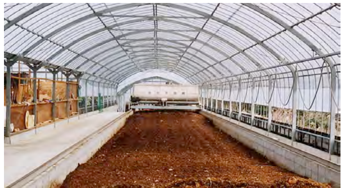
完成した本格的な生ごみ堆肥化実験プラント この施設は市民ファンドと伊万里信用金庫の支援を受けて完成しました。生ごみの分別回収方法のシステム化、年間を通した大量の生ごみに対する堆肥化技術の確立等を目指して、佐賀大学の協力を 受け実証実験を開始しました。
